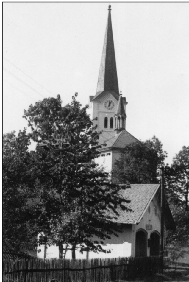
Bývalá hasičská zbrojnice pod kostelem
