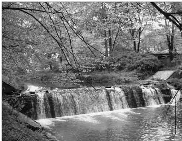
Jez na Husím potoce nad železniční tratí
